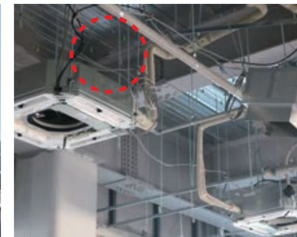
吊り機器の制震・制振補強「柔(にゅー)ワイヤ工法」 赤丸部分
