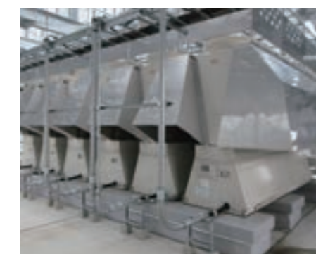
防雪フードと積雪対策基礎台
